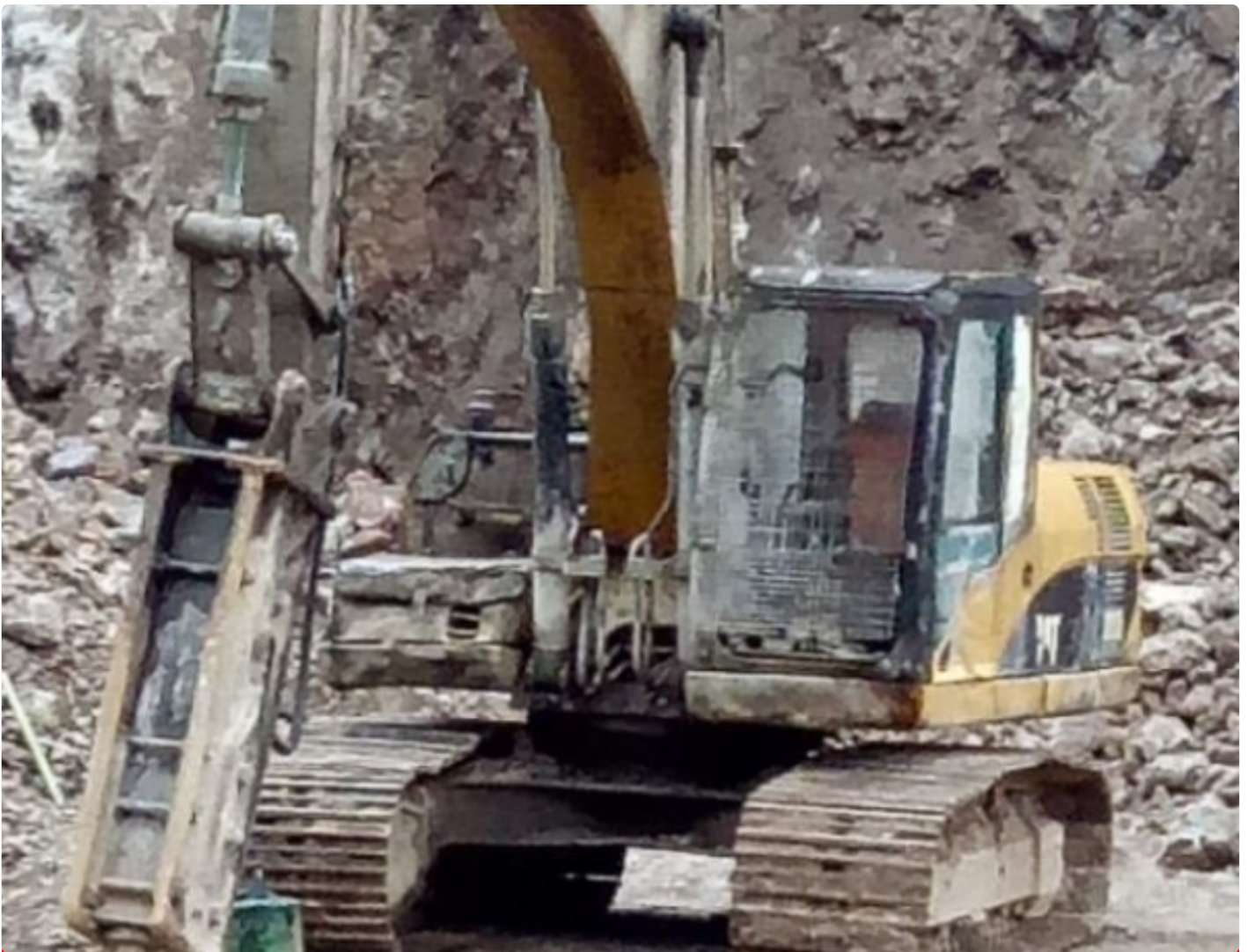
Ekskavator milik PT Bakapindo
